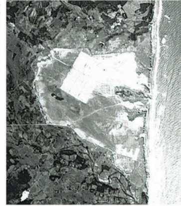
戦後間もない1947年に撮影された旧磐城飛行場を捉えた写真(国土地理院提供)
