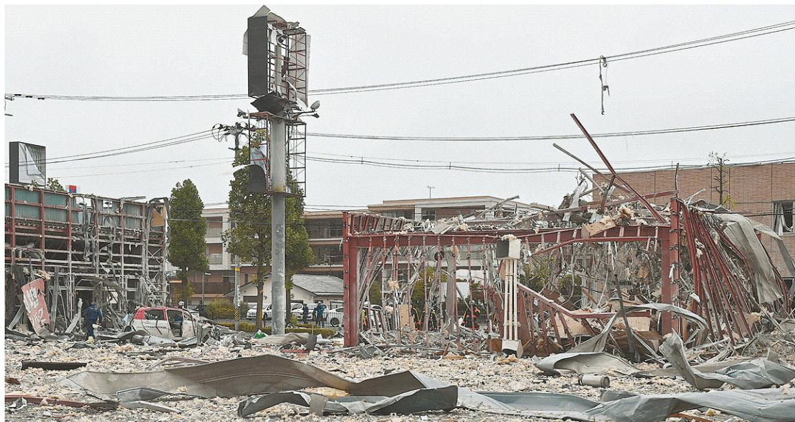
ガス爆発の現場。断熱材の破片が散乱し建物の鉄骨だけが残っている=30日午前10時30分ごろ、郡山市島
