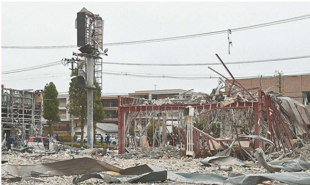
ガス爆発とみられる現場。断熱材の破片が散乱し建物の鉄骨だけが残っている=30日午前10時30分ごろ、郡山市島
