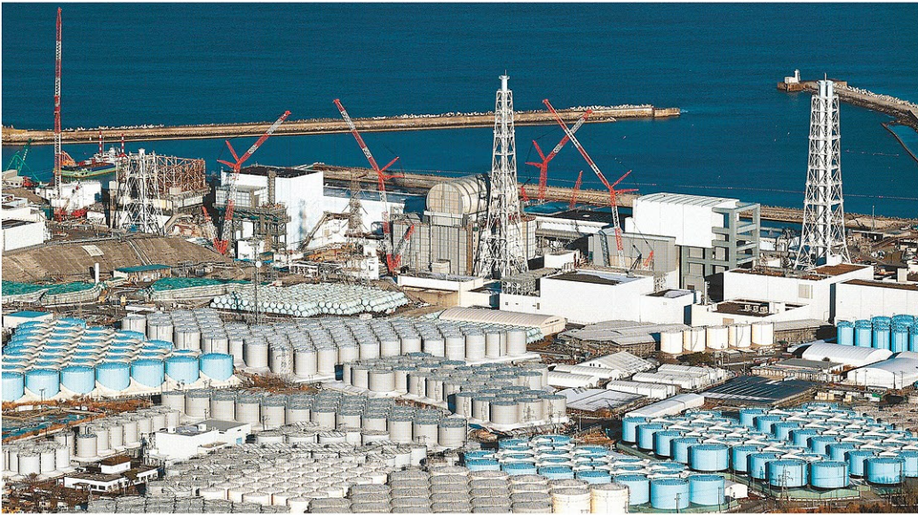
東京電力福島第1原発の敷地内に林立する、汚染水を浄化した後の処理水などを保管するタンク。奥左から1、2、3、4号機=1月(共同通信社ヘリから)
